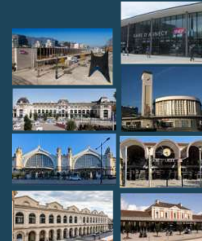
Bâtiments : Etudes de vulnérabilités des gares – Gares & Connexion
